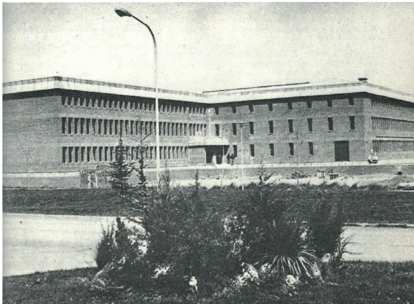
Figura 7. Vista de la primera fase del edificio en 1982 (Tomada de Cordero del Campillo, 1983:429).
